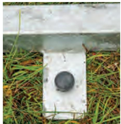
Bodenplatte mit Erdnagel
