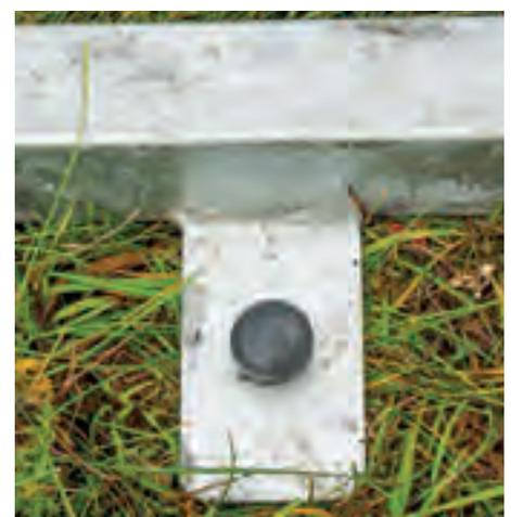
Bodenplatte mit Erdnagel
