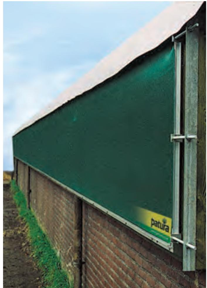
Fest installierte Windschutznetze mit Alu-Profilen und Spannvorrichtung
