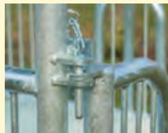
Ausklappbare Seitenteile durch Steckbolzen
