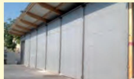
Die Breite des Tores muss vor Ort auf die Öffnungsbreite zugeschnitten werden, zum Höhenausgleich kann ein Rest auf dem oberen Rohr aufgewickelt bleiben.
