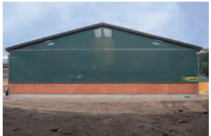
Fest installiertes Netz oben mit Kederprofil und unten mit Hohlsaum. Verspannung über Stahlrohr im Hohlsaum, in Verbindung mit Ratschen.
